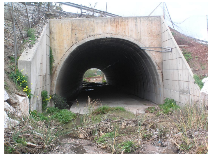
F1 Sección bóveda aguas arriba
