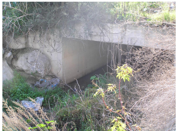
F2 Sección obra de drenaje transversal aguas arriba
