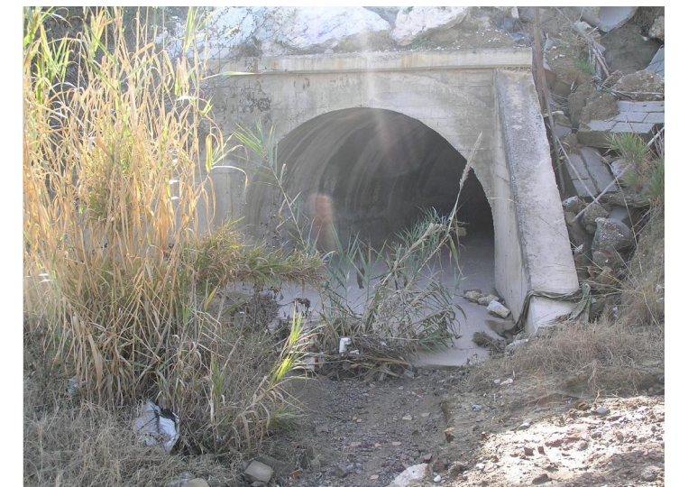
F2 Sección bóveda aguas arriba
