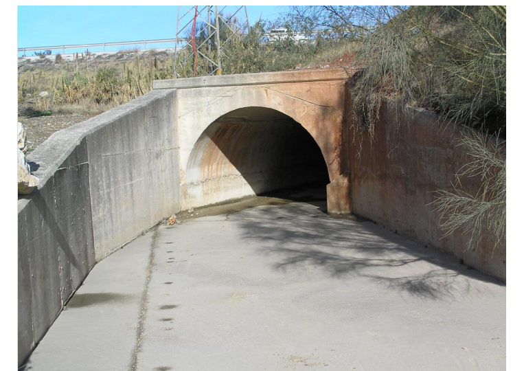
F4 Sección bóveda agua abajo
