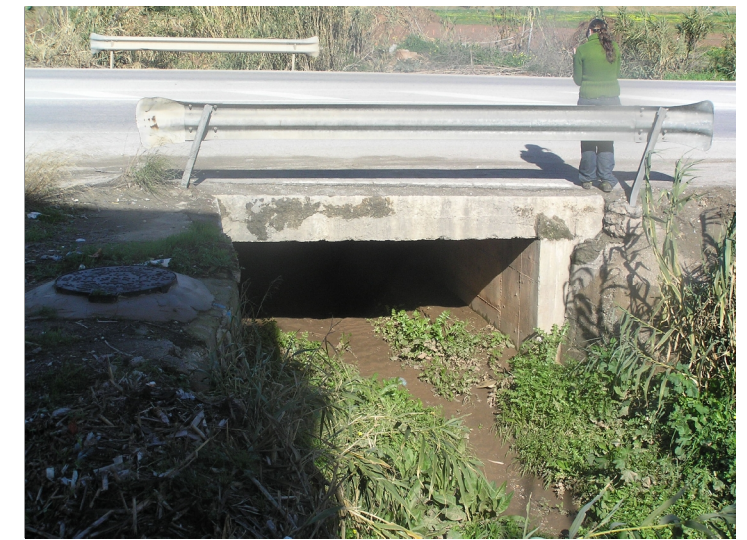
F2 Sección obra de drenaje transversal aguas abajo
