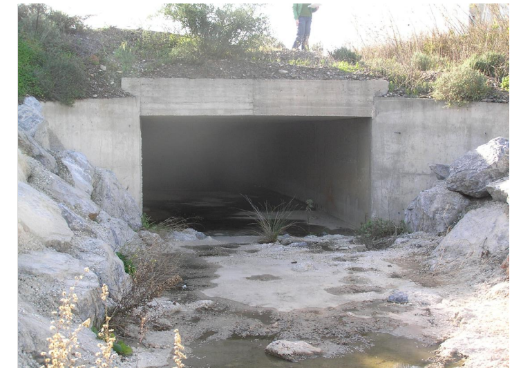
F2 Sección obra de drenaje transversal aguas arriba
